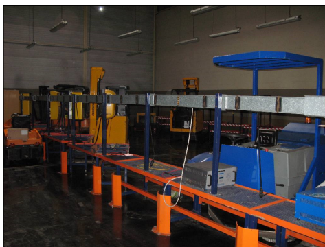
Photo 1 : Salle de charge des gros appareils
